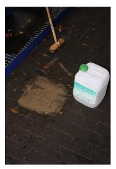
Die 10% ige Lösung wurde aufgetragen und mittels Bürste in die Fläche eingearbeitet. Hierbei werden die KW in kleine Mizellen aufgespalten und an die Oberfläche transportiert.
