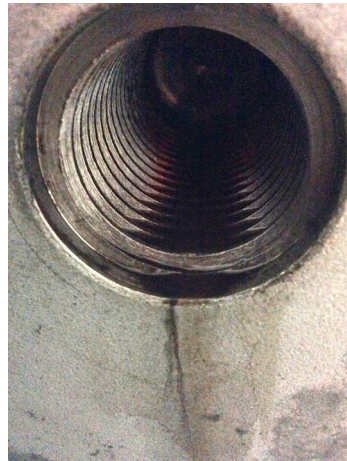
Sprühreinigung mit RSG-3034
